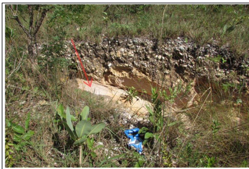
Figura 7. Representação do ponto 29, onde o antigo leito paralelo da trilha foi transformado em um canal efêmero de escoamento pluvial, evidenciando o impacto das mudanças no uso dos leitos ao longo do tempo. Acervo pessoal, 2023
